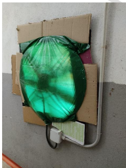
Ilustración 77.- Sistemas de ventilación y renovación de aire cubiertos y bloqueados en plantas visitadas.
