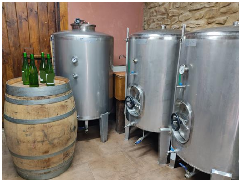
Ilustración 52.- Acceso a la zona de depósito en sidrería.
