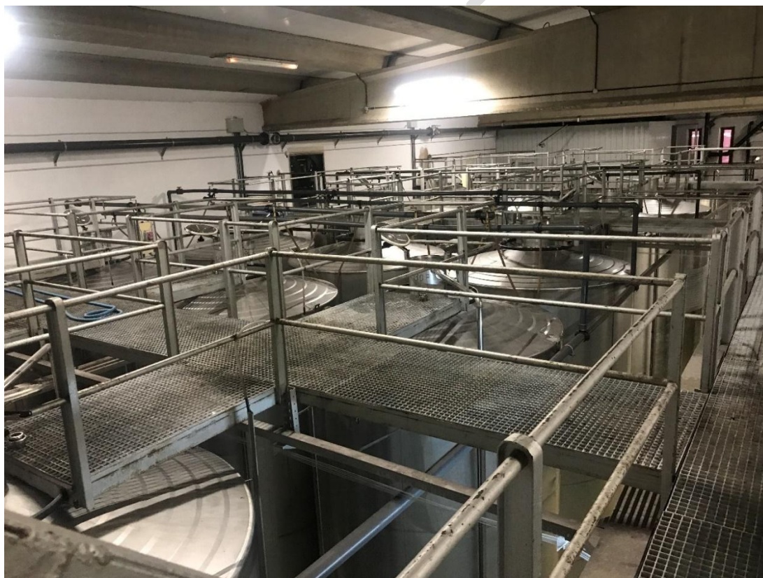
Ilustración 47.- Acceso a la parte superior de depósitos en bodega.
