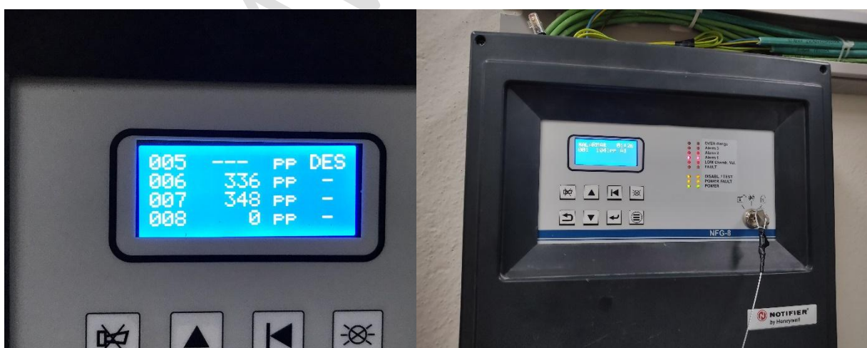
Ilustración 78.- Sistemas de ventilación y renovación de aire activado por detección en plantas visitadas.
