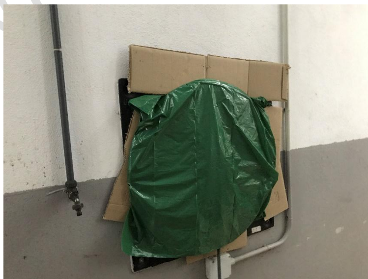
Ilustración 77.- Sistemas de ventilación y renovación de aire cubiertos y bloqueados en plantas visitadas.
