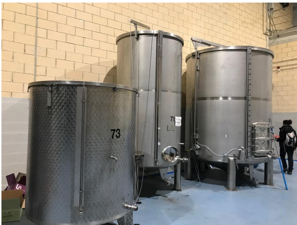
Ilustración 50.- Acceso a la zona de depósito en bodega.
