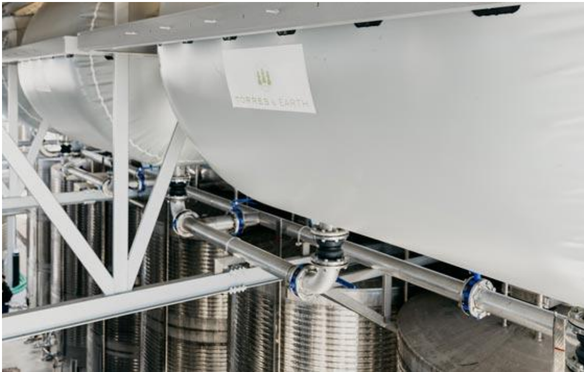
Ilustración 39.- Imagen de sistema de recuperación de CO2 de fermentación en vino por la Familia Torres. Obtenido de https://www.tecnovino.com/asi-es-el-sistema-pionero-que-recoge-y-reutiliza-co2-de-la-fermentacion-del-vino-con-el-que-familia-torres-espera-capturar-20-toneladas-de-co2/
