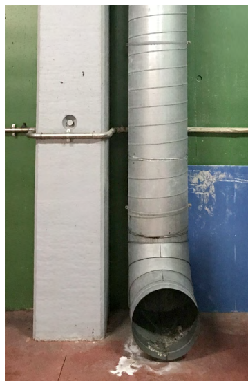
13. irudia: Aireztapen behartuko sistema finkoak gasak detektatzeko sistemara konektatuta, eta ohiko baldintzetan funtzionamendu aldien araberako programazioarekin
