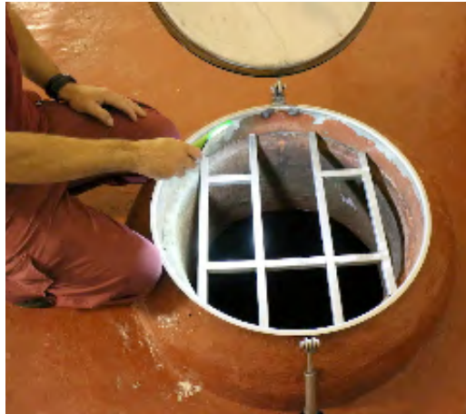
11. irudia: Hartzidura deposituak, segurtasuneko ainguraketa sistemekin (goian) eta erorketen aurkako sistemekin (behean)
