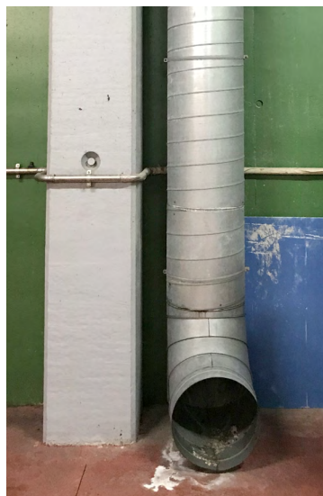
Imagen 13: Sistemas fijos de ventilación forzada conectado a sistema de detección de gases y con programación por periodos de funcionamiento en condiciones normales.
