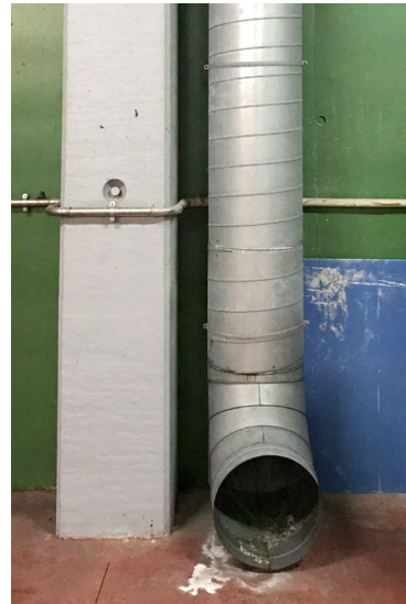
13. irudia: Aireztapen behartuko sistema finkoak gasak detektatzeko sistemara konektatuta, eta ohiko baldintzetan funtzionamendu aldien araberako programazioarekin
