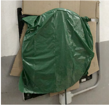
12. irudia: Aireztapen behartuko sistema finkoak: Egoera zuzena (ezkerrean) eta okerra (eskuinean)
