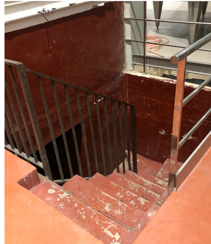
Imagen 2: Zonas donde se puede acumular el tufo por ventilación deficiente
