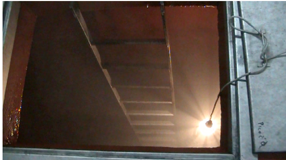
Imagen 8: Limpieza manual de depósitos
