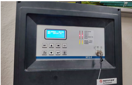
Imagen 15: Sistema de sensor de CO 2 y central de alarma
