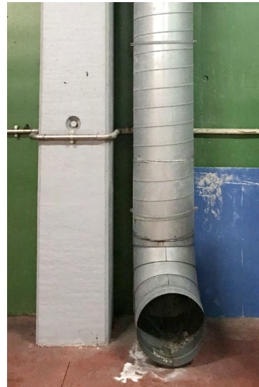
Imagen 13: Sistemas fijos de ventilación forzada conectado a sistema de detección de gases y con programación por periodos de funcionamiento en condiciones normales.
