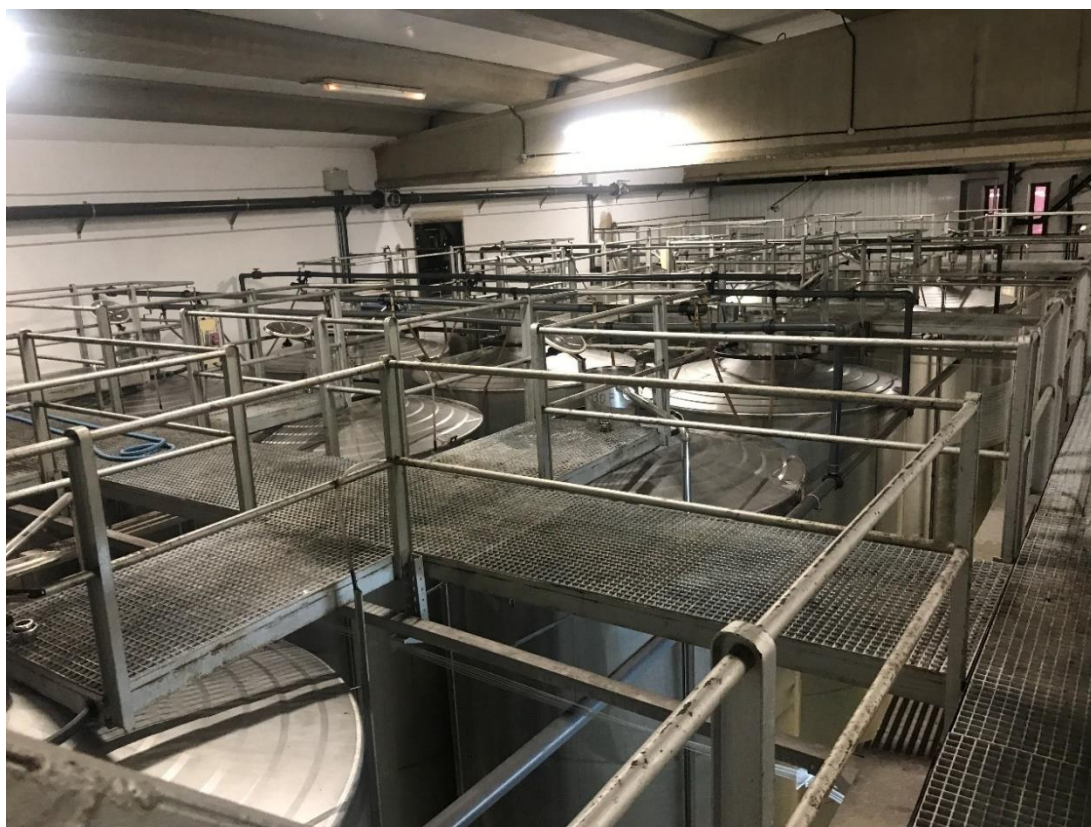
Ilustración 36.- Acceso a la parte superior de depósitos en bodega.
