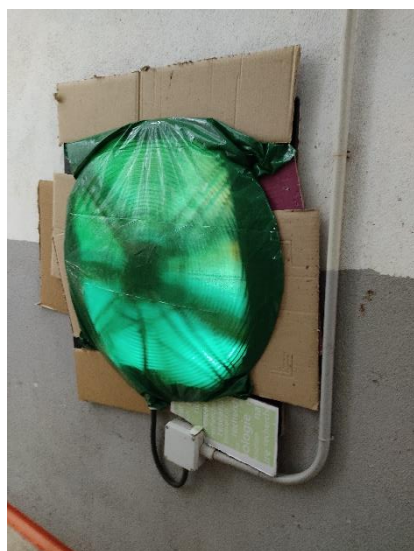
Ilustración 66.- Sistemas de ventilación y renovación de aire cubiertos y bloqueados en plantas visitadas.
