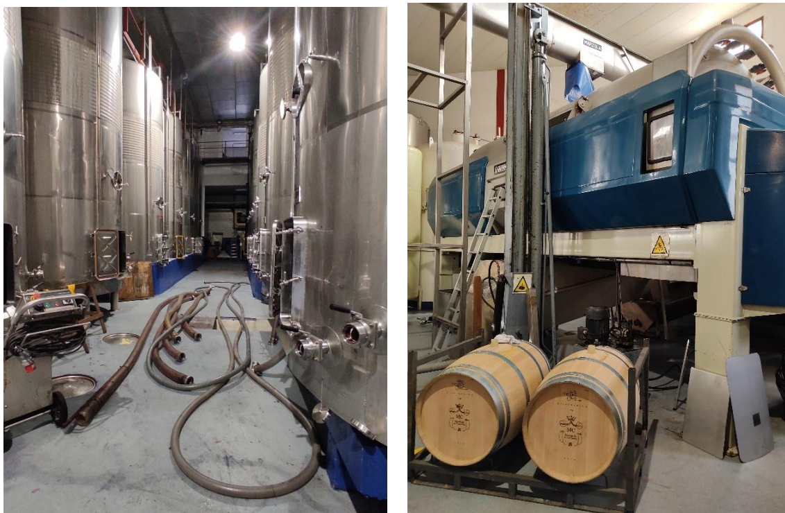
Ilustración 40.- Acceso a la zona de depósito de fondo plano y zona de barrica.
