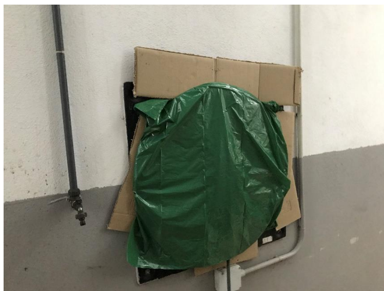
Ilustración 66.- Sistemas de ventilación y renovación de aire cubiertos y bloqueados en plantas visitadas.
